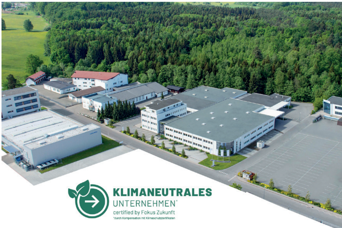
© Copyright SONOTRONIC Nagel GmbH Klimaneutrales Unternehmen mit nachhaltigen Lösungen im Nordschwarzwald - Hauptsitz Karlsbad-Ittersbach
